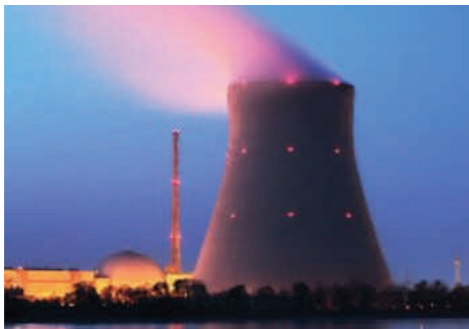
Efektywne oświetlenie elektrowni jądrowej, Indie
