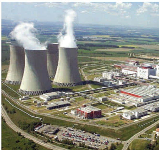
Elektrownia jądrowa w Temelinie (Czechy) Źródło: energetyka.pl
