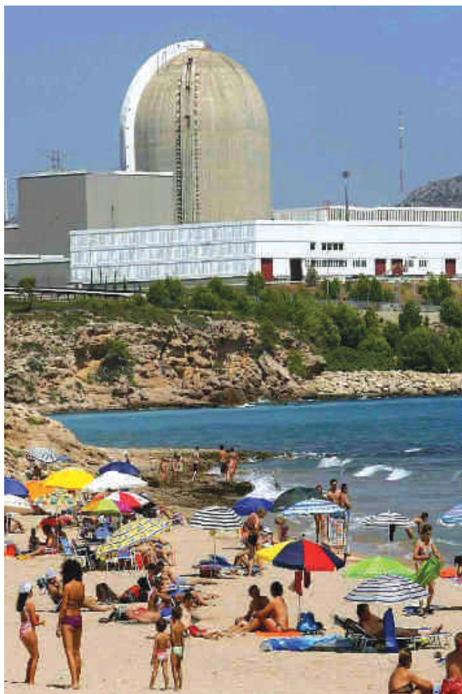
Elektrownia jądrowa Vandellos (fot. ENDESA)
