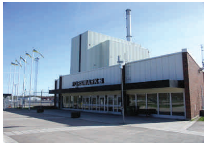
Elektrownia jądrowa w Forsmark, Szwecja
