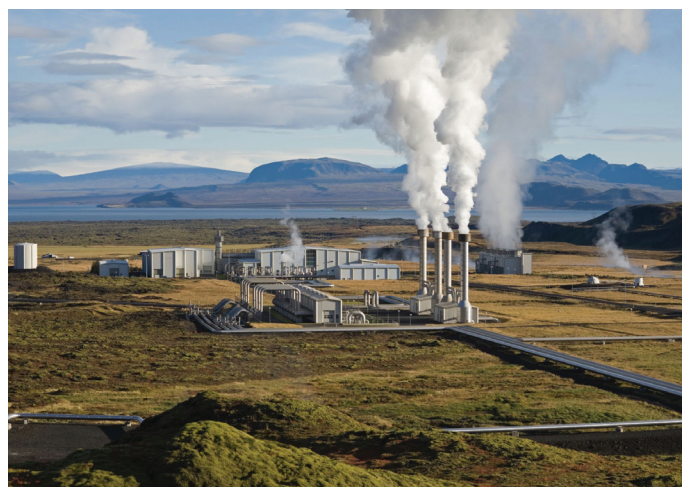
Rys. 61. Elektrownia geotermalna (źródło: wikipedia.org)
