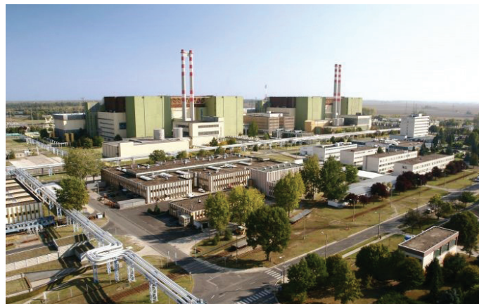
Rys. 36. Elektrownia jądrowa w Paks
