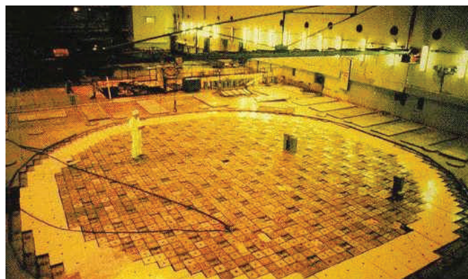
Rys. 33. Widok korpusu reaktora typu RBMK. Widoczne „kwadraciki” o boku 25 cm, skrywają 2488 bloków moderatora grafitowego. We wnętrzu 1661 bloków znajdują się kanały ciśnieniowe z paliwem i systemem chłodzenia wodą. Ponadto, w 222 blokach były zamontowane pręty sterujące. Średnica reaktora to ok. 12 m, wysokość zaś – 7 m. W porównaniu z konstrukcjami typowych reaktorów PWR i BWR, gdzie średnio wysokość prętów paliwowych wynosi około 3,6-3,8 m natomiast średnica reaktora to około 3.3 m. Rdzeń reaktora RBMK był bardzo duży, przez co operator mógł mieć problemy z kontrolą jego mocy
