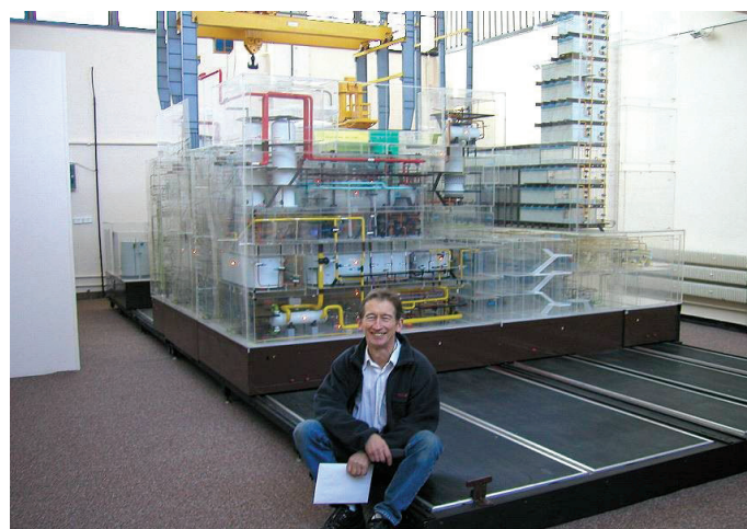
Rys. 12. Model elektrowni WWR-440 eksponowany w NCBJ w Świerku. Z prawej strony widać wyraźnie wieżę likwidacji nadciśnienia awaryjnego. Na pierwszym planie p. Tadeusz Sworobowicz – jeden z techników pracujących przy rekonstrukcji modelu
