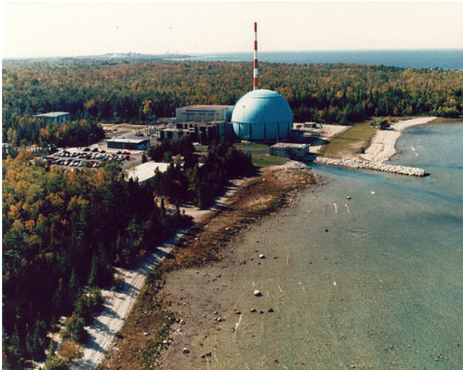
Rys. 20. Elektrownia jądrowa Big Rock Point w USA. Posiadała ona typową dla wczesnych konstrukcji obudowę bezpieczeństwa w postaci dużej, stalowej kuli
