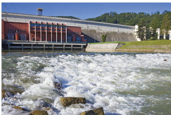
Rys. 60. Elektrownia wodna (źródło: wikipedia.org)
