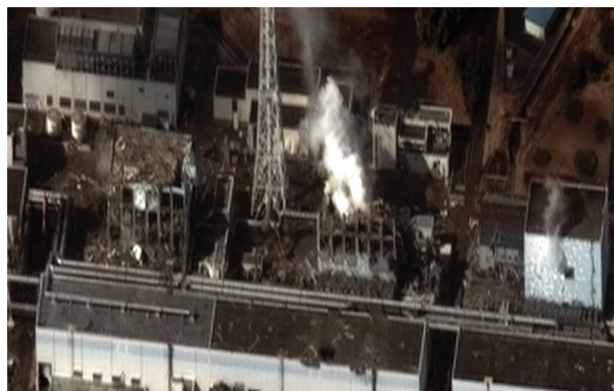
Rys. 39. Zniszczenia elektrowni 1-4 w elektrowni Daii-chi (źródło: Wikipedia Commons)
