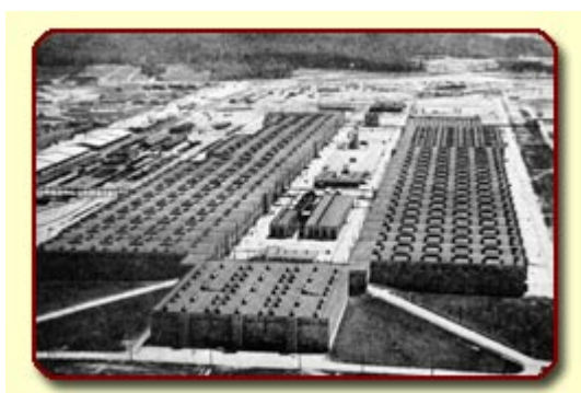
Rys. 5.7. Zakłady dyfuzji gazowej K-25 w Oak Ridge. Ta czteropiętrowa instalacja miała prawie 800 m długości i zajmowała łączną powierzchnię niemal 180 000 m 2
