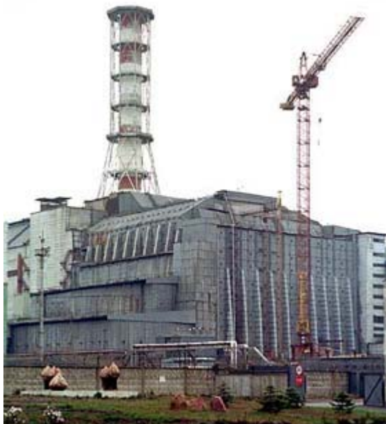
Rys. 16.10 Sarkofag wokół zniszczonego reaktora
