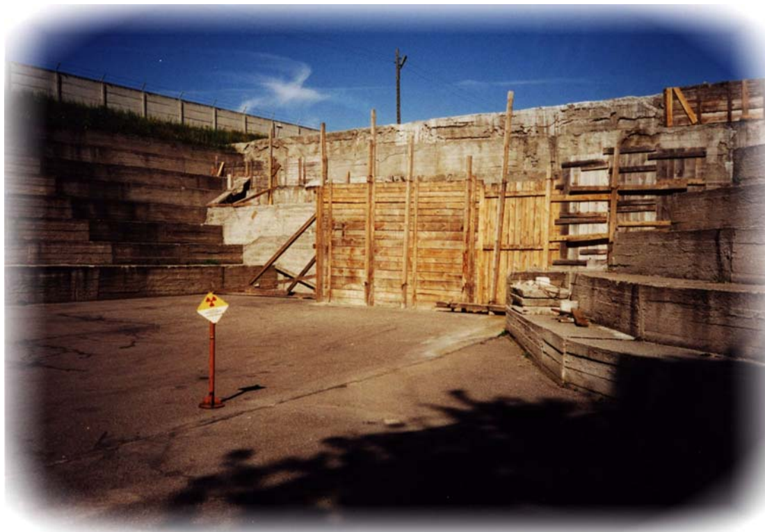
Rys. 9.8 Fragment fosy w Krajowym Składowisku Odpadów Promieniotwórczych w Róźnie. Część fosy jest już wypełniona i zamknięta pionową ścianą betonową.
