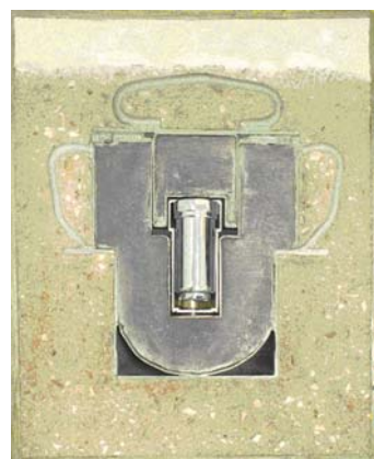
Pojemnik na zużyte igły radiowe. Igły wkłada się do pojemniczka stalowego, który jest otoczony grubą warstwą ołowiu, ta zaś betonem i (od góry) ziemią okrzemkową. Grubość stali pojemnika wynosi 5 mm.
